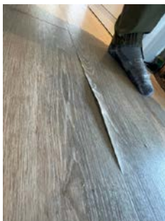
Løs vinylflis i gang utbedret av eier.
