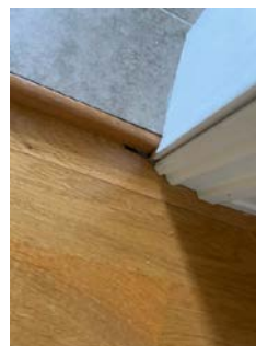
Stedvis synlige glipper mellom gulv og list
