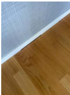
Løs vinylflis i gang utbedret av eier.
