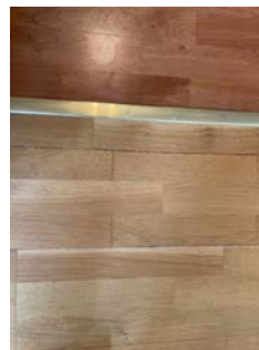
Stedvis synlige glipper mellom gulv og list
