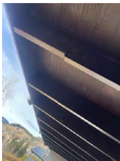
Skjøter i bjelker i lengderetning.
