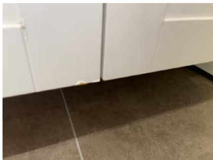
Eksempel på svelling i fronter
