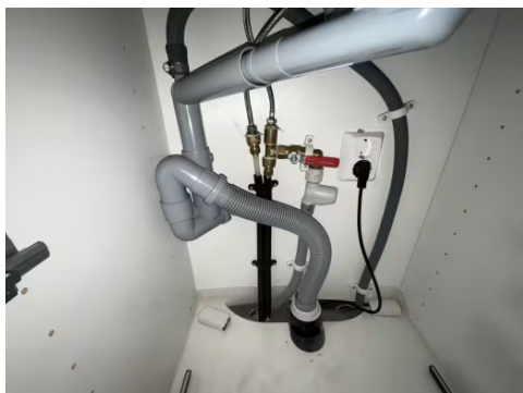
Viser vann og avløpsinstallasjoner under kum.
