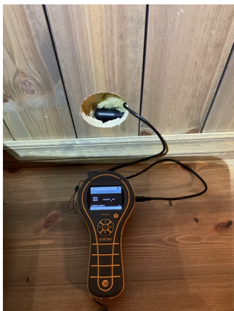
Det er foretatt hulltaking med 73 mm hullbor fra tilstøtende rom (soverom). Undersøkelsen viser ingen tegn til skader eller fukt i konstruksjonen.
