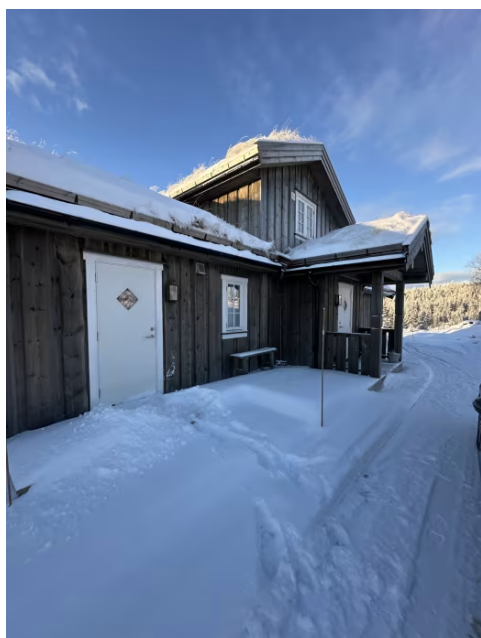
Viser terrasse og overbygget inngangsparti.
