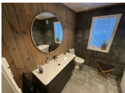
Viser baderomsinnredning og gulvstående toalett.
