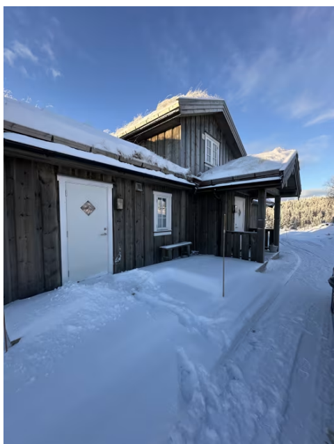
Viser terrasse og overbygget inngangsparti.
