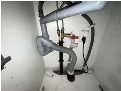
Viser vann og avløpsinstallasjoner under kum.
