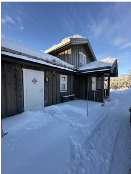
Viser terrasse og overbygget inngangsparti.
