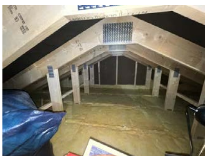
Viser loft isolert med mineralull.
