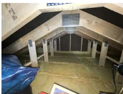
Viser loft isolert med mineralull.
