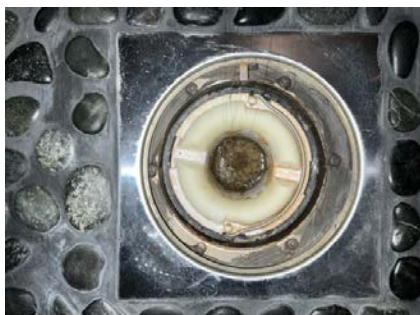
Viser sluk i dusjsonen.
