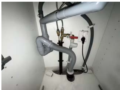
Viser vann og avløpsinstallasjoner under kum.
