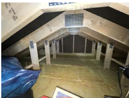
Viser loft isolert med mineralull.
