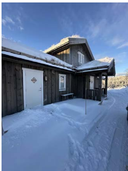
Viser terrasse og overbygget inngangsparti.
