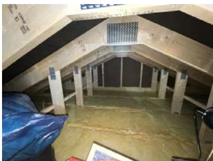
Viser loft isolert med mineralull.
