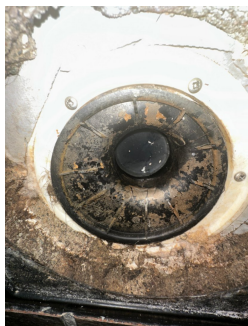
Plastsluk med klemring for membran
