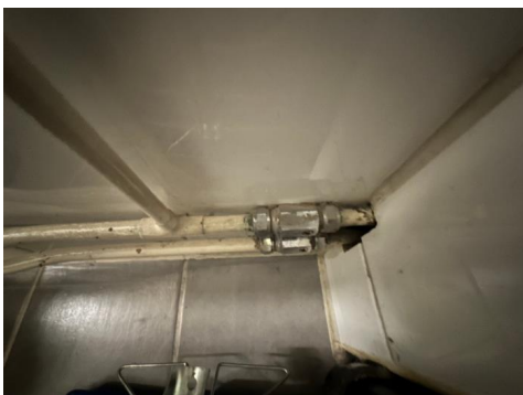
Stoppekraner plassert på bad
