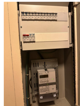
Sikringskap med automatsikringer.
