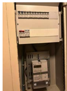
Sikringskap med automatsikringer.
