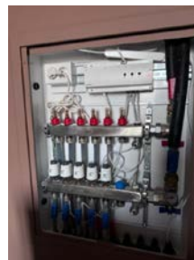
Vannfordelere til gulvvarmen 2. etasje er montert i veggen mot badet på det ene soverommet i 2. eta
