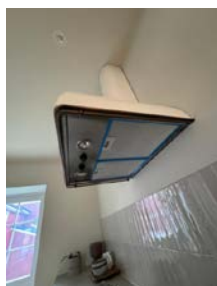
Sensor for komfyrvakt mangler.
