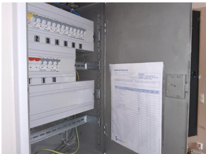
Beskrivelse - [Sikringsskap med kursfortegnelse. ]
