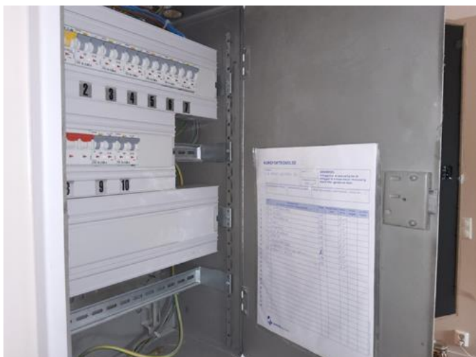
Beskrivelse - [Sikringsskap med kursfortegnelse. ]
