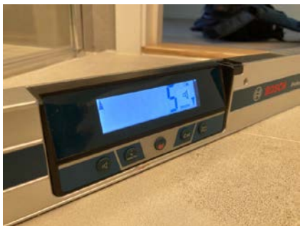
Målt fall ved dør
