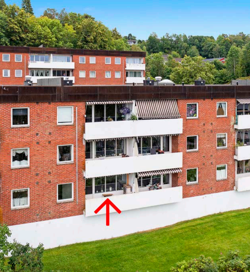
Leiligheten ligger i 1. etasje, men likevel høyt i terrenget.
