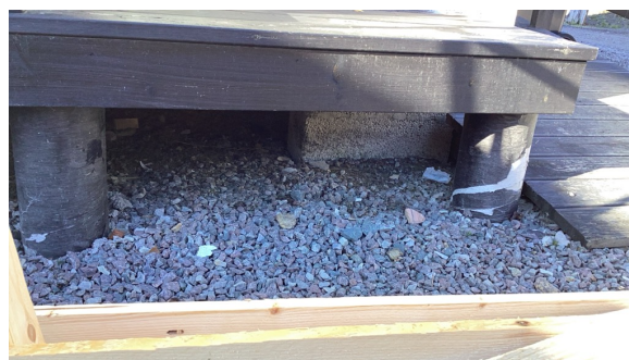
Fundamentering av tilbygget entre.
