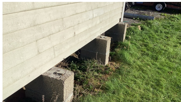
Fundamentering av tilbygget bod.
