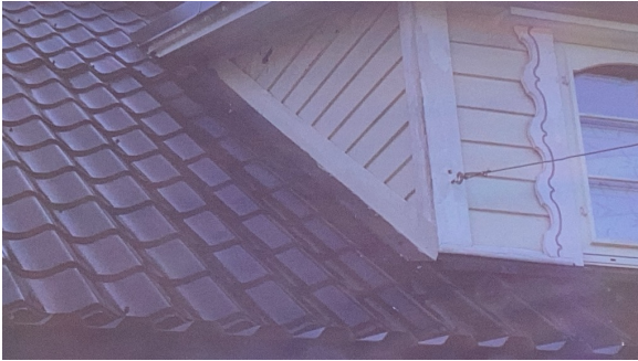
Beslag mot takløft er lagt utenpå kledning
