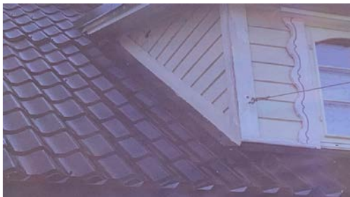
Beslag mot takløft er lagt utenpå kledning
