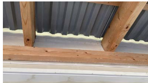
Det er ikke tett overgang mellom tak og vegg.
