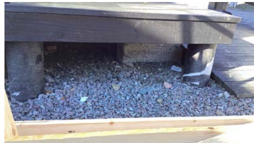
Fundamentering av tilbygget entre.
