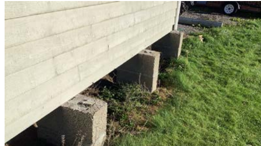
Fundamentering av tilbygget bod.
