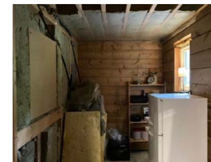
Uinnredet rom 1.etasje.
