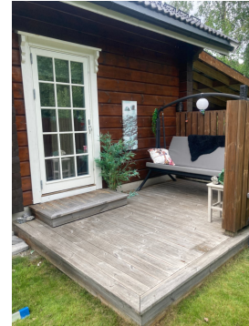
Terrasseplattning med levegger utenfor soverom.
