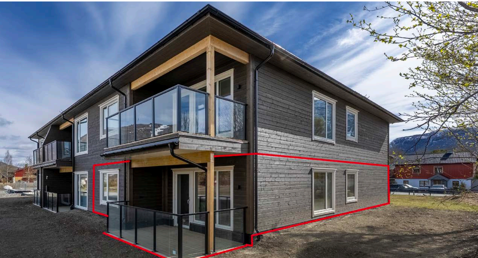
Fasade med markering
