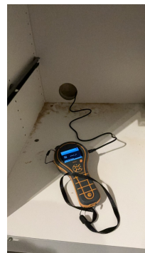
Hulltaking gjennom garderobeskap på soverom mot våtsonen/ dusjsone.
