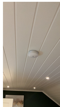
Røykvarsler. Funksjonstestet. OK.
