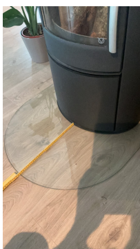
Avstand til brennbart materiale fra ovn
