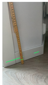
Høyeste avvik på 10mm målt gjennom hele rommet i stue/ kjøkken.
