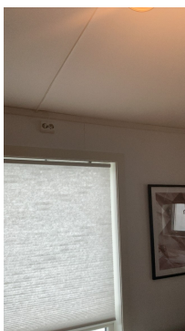
Riss i plateskjøt over vindu i stue
