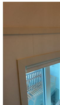
Riss i plateskjøt over vindu i trappa
