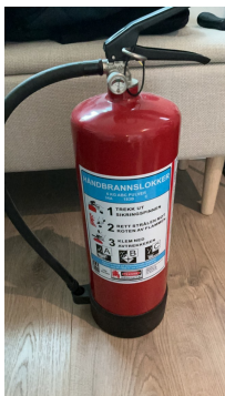
Pulverapparat. Mangler datostempling
