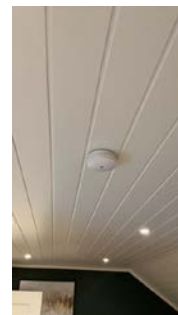
Røykvarslere. Funksjonstestet. OK.
