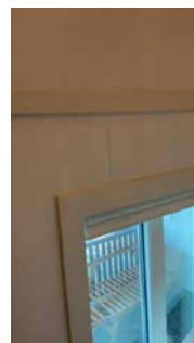
Riss i plateskjøt over vindu i trappa
