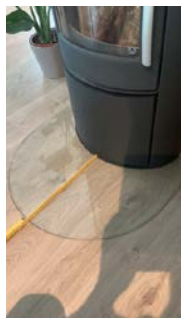
Avstand til brennbart materiale fra ovn
