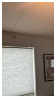
Riss i plateskjøt over vindu i stue
