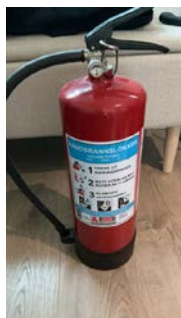
Pulverapparat. Mangler datostempling
