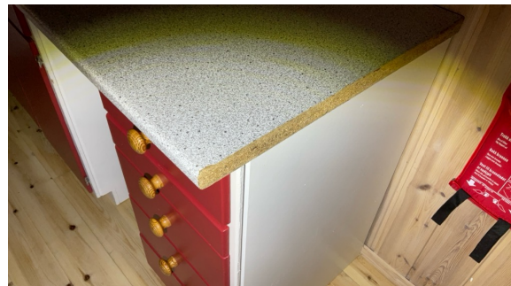
Manglende kantfiner på løs benkeplate.
