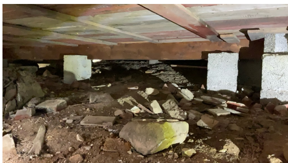
Fundamenter i lettklinkerblokker.
