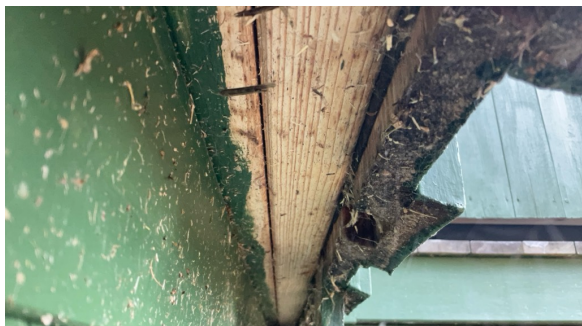
Underbord montert rett på vindsperre.
