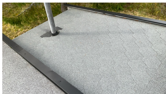
Nyere shingel på tilbygg.
