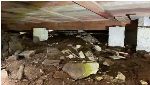
Fundamenter i lettklinkerblokker.
