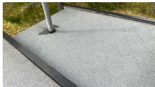
Nyere shingel på tilbygg.
