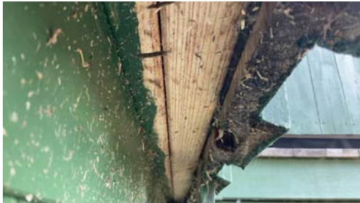
Underbord montert rett på vindsperre.
