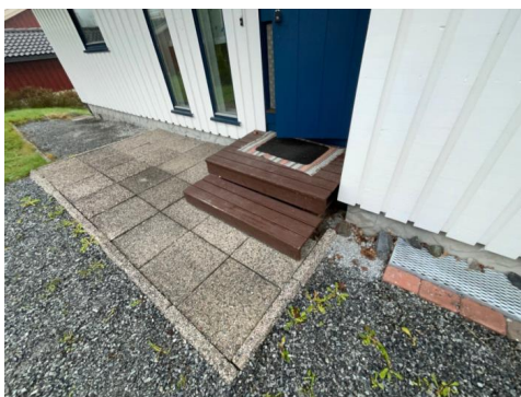
Det er ikke rekkverk, som kreves der det er høyde over 50 cm.
