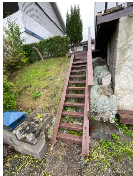
Enkel smal yttertrapp som følger terrenget.
