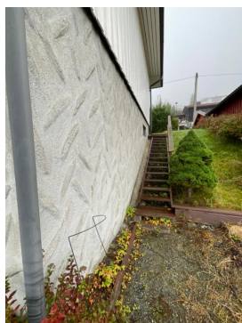
Enkel smal yttertrapp som følger terrenget.
