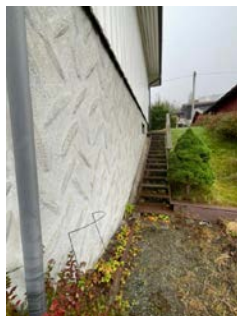
Enkel smal yttertrapp som følger terrenget.
