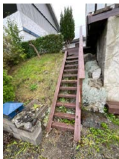
Enkel smal yttertrapp som følger terrenget.
