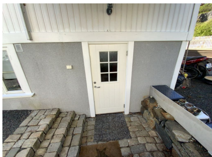
Hoveddør til kjelleretasjen
