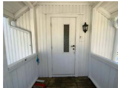
Hoveddør til 1. Etasje
