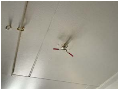
Løse ledninger i taket på soverom i 2. Etasje
