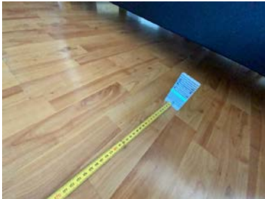
Lokalt avvik (2m) på 12mm høydeforskjell
