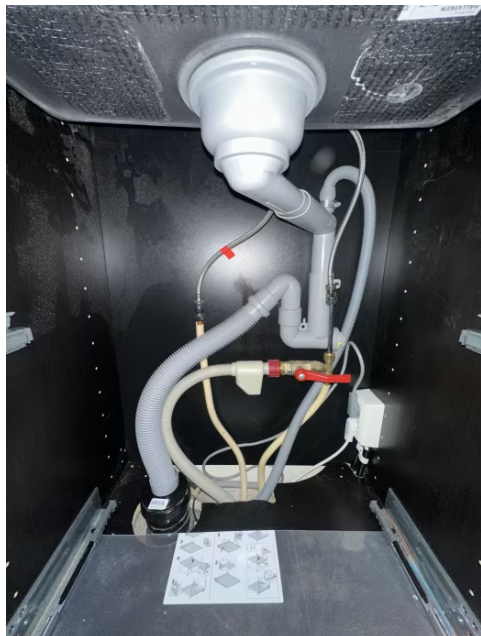
Viser vann og avløpsinstallasjoner under kum.
