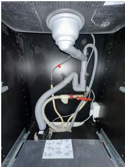
Viser vann og avløpsinstallasjoner under kum.
