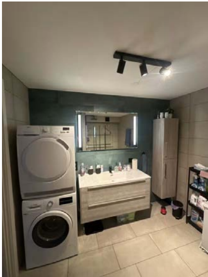
Viser baderomsinnredning og opplegg for vaskemaskin.
