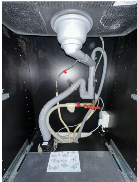
Viser vann og avløpsinstallasjoner under kum. Ettermontert vannstoppeventil.
