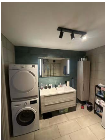
Viser baderomsinnredning og opplegg for vaskemaskin.
