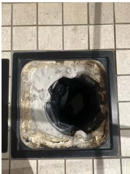
Viser sluk i dusjsonen.
