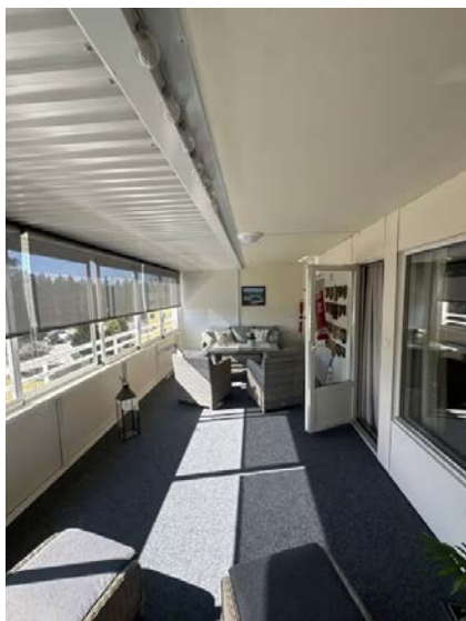
Viser innglasset balkong.
