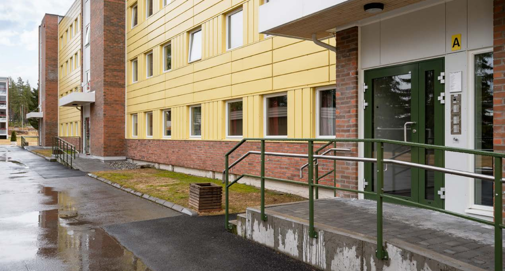
Grøndalsbakken Borettslag er et veldrevet borettslag med god vedlikeholdshistorikk.
