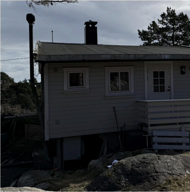
Byggets nordøstlige hjørne
