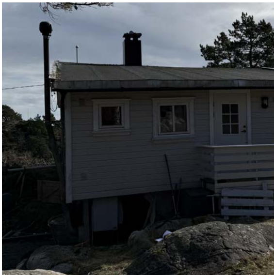
Byggets nordøstlige hjørne
