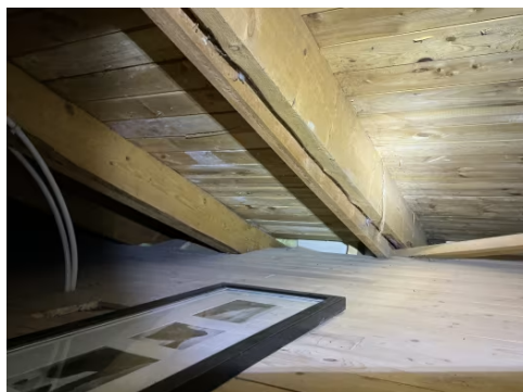
Takkonstruksjon er kunn kontrollert fra luke i tak.
