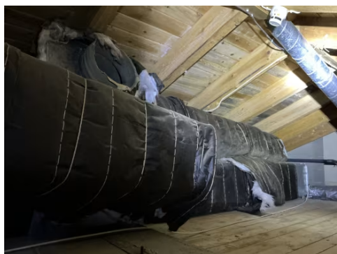
Rester etter ventilasjons-kanaler på kaldt loft.
