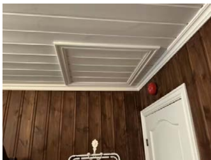
Tilkomst til kaldt loft gjennom luke i tak på soverom.
