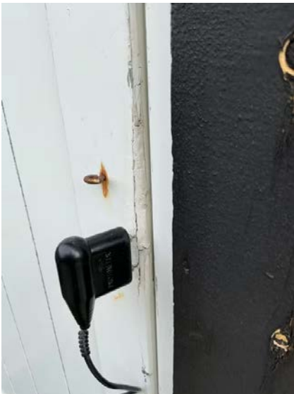
Større sprekker/skade på dørblad til terrassedør TG 3.
