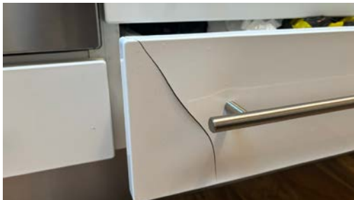
Sprekker i folieringen på kjøkkenet
