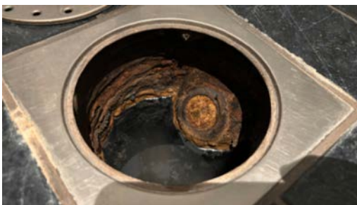
Eldre sluk i støpejern
