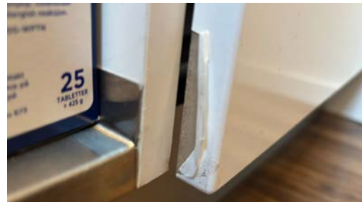
Sprekker i folieringen på kjøkkenet
