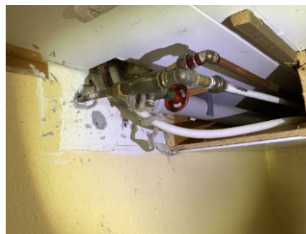
Innvendig stoppekran med tapping på utekran.
