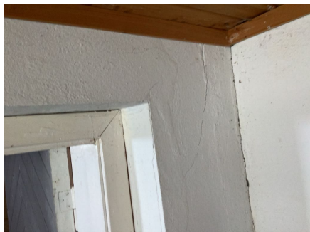
Rissprekker i grunnmur er registrert.
