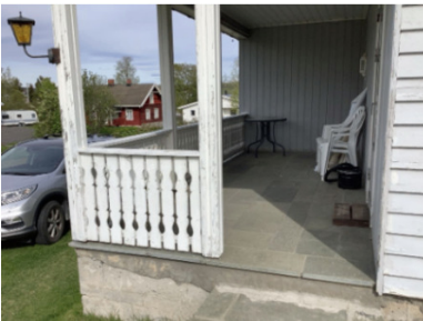
Veranda mot nordvest.
