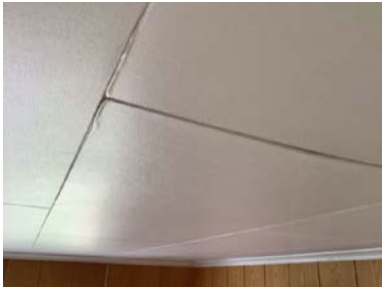
Folieslipp på himlingsplater.
