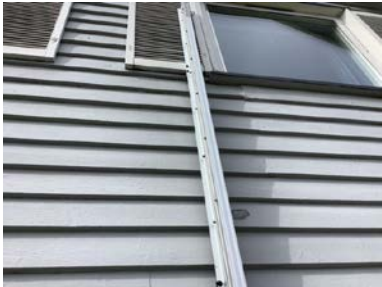
Det er montert brannstige fra soverom på loftetaje.
