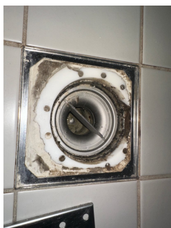
Stålsluk med klemring for membran i leilighet
