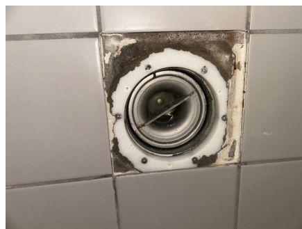
Stålsluk med klemring for membran i hybel
