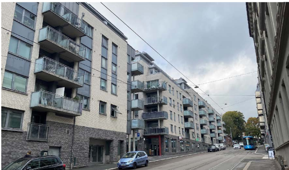
Stor vannføring i Tofte's gate ved sterk nedbør kan føre til vanninntrengning
