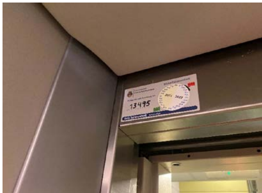
Kontrollmerke. Sikkerhetskontroll utføres annet hvert år
