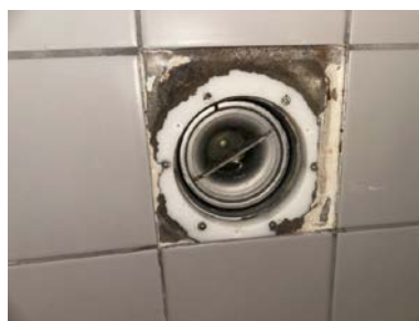
Stålsluk med klemring for membran i hybel
