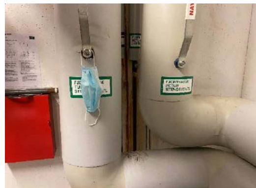
Stengeventiler for fjernvarme
