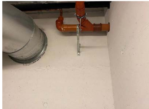
Lett tilgjengelige avløpsrør i kjeller
