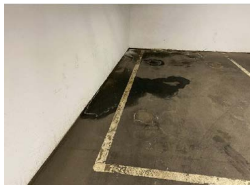
Overflater i parkeringskjeller
