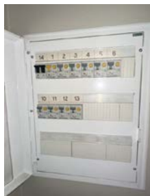
Sikringsskap med automatsikringer.
