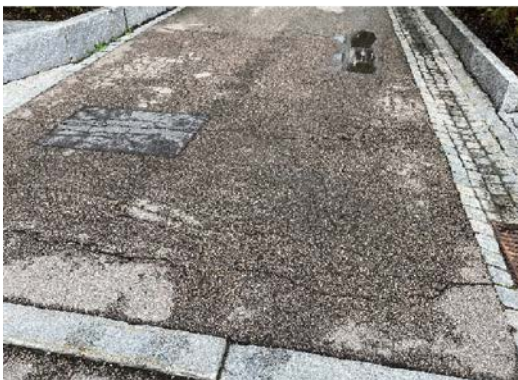
Asfaltskader
