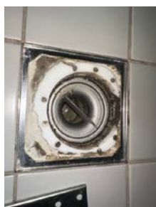
Stålsluk med klemring for membran i leilighet
