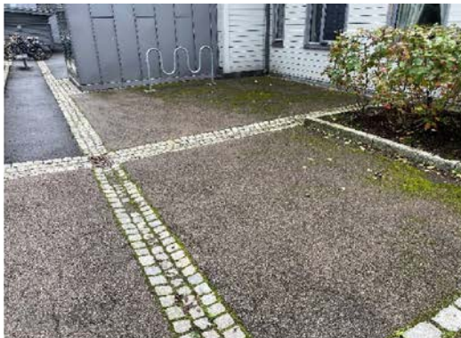
Sørg for åpne overvannsrenner
