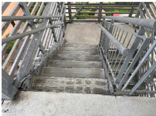
Betong i inntrinn
