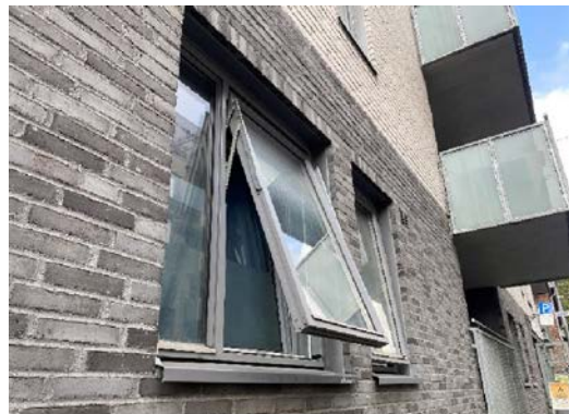
Vinduer med toppsvingmekanisme
