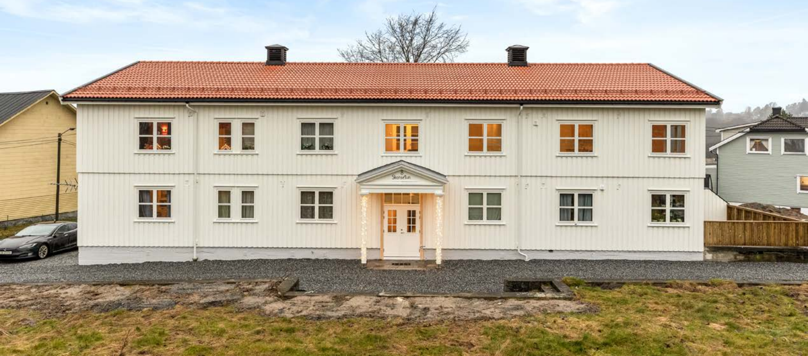
Bygningen består av 8 leiligheter.
