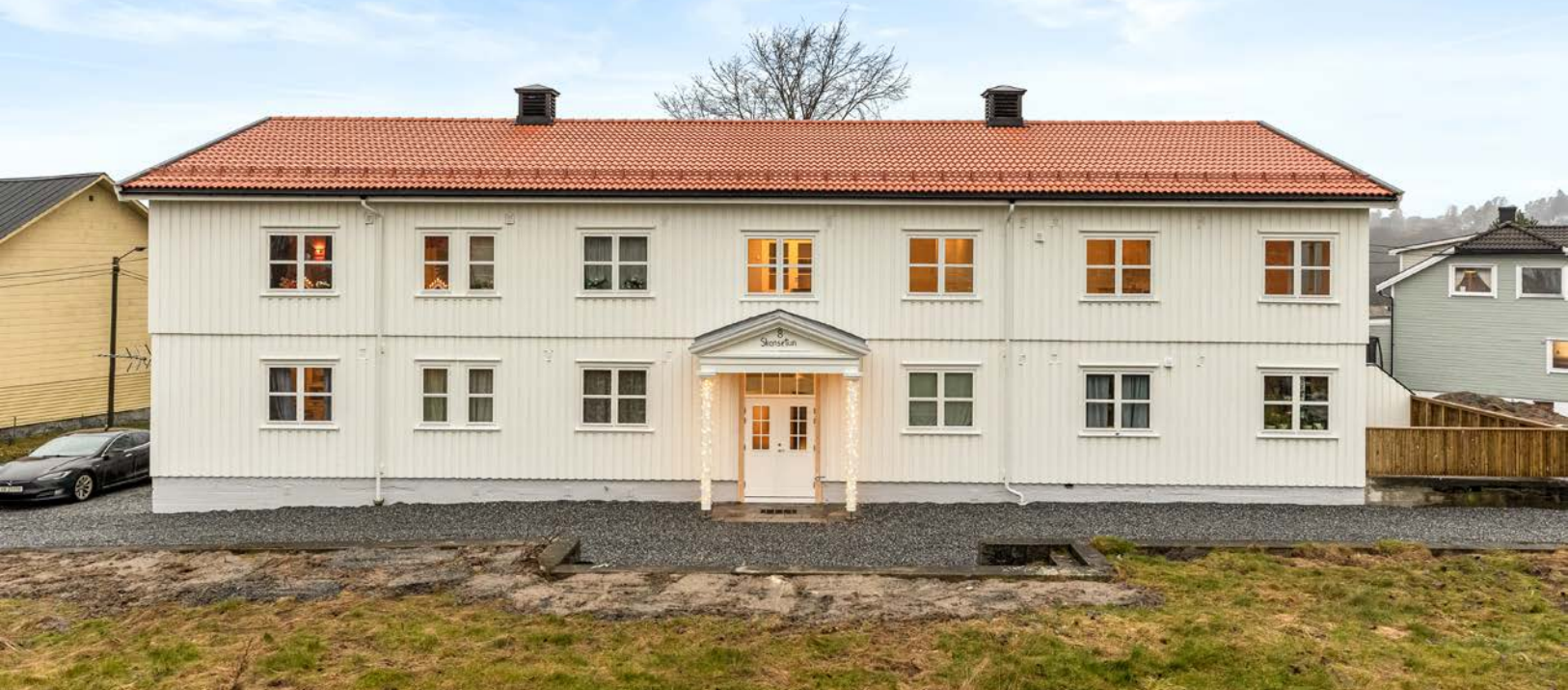
Bygningen består av 8 leiligheter.
