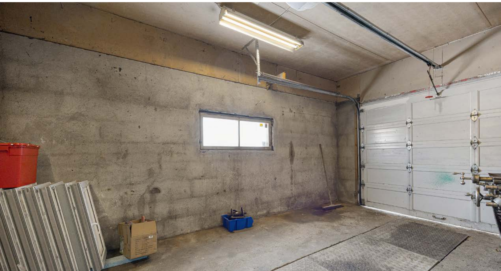
Bildet viser en av garasjene innvendig.
